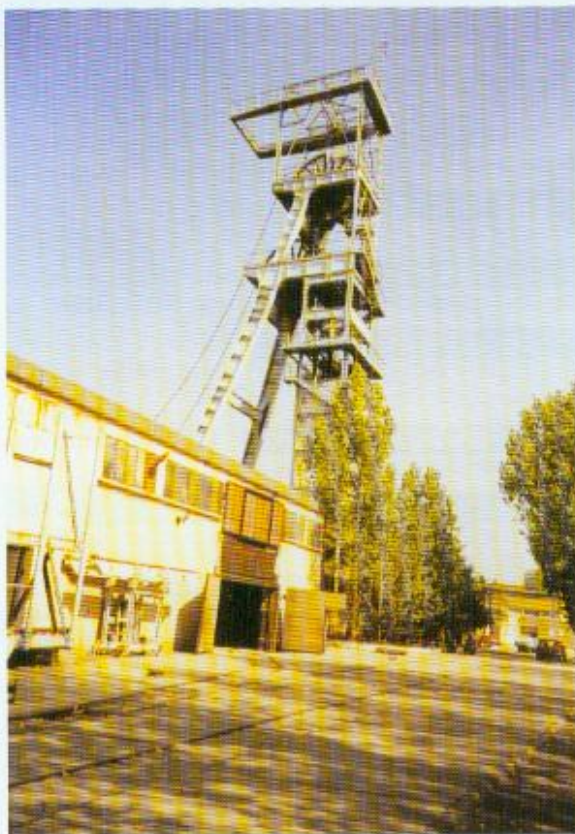
Widok wieży szybowej P-III – górne koło linowe przygotowane do naprawy.
